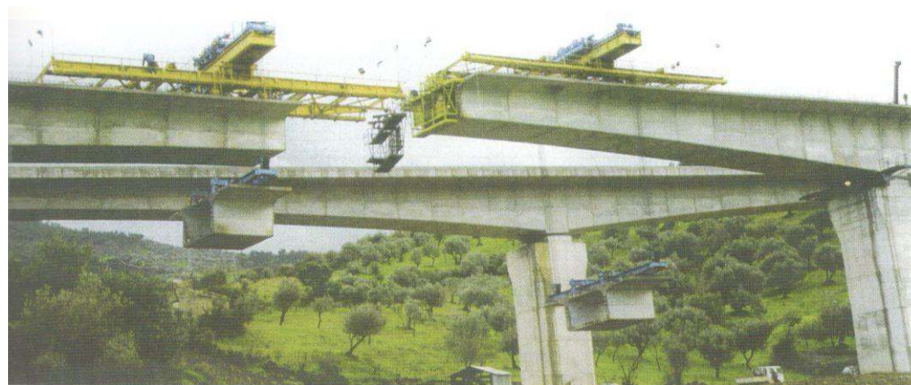
Segmentna izgradnja vijadukta na Siciliji
