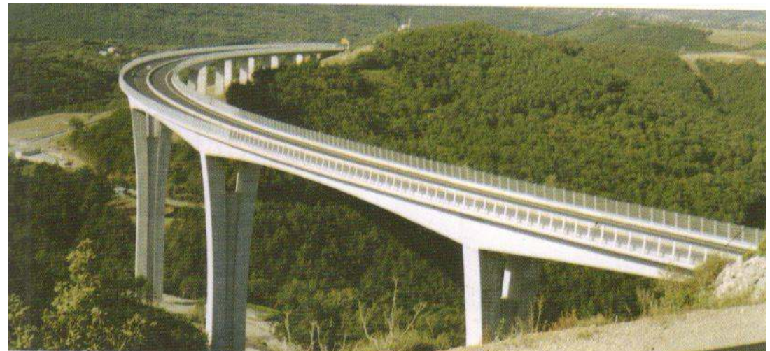
Viadukt Černi kal na autoputu Ljubljana-Kopar, 2002.
