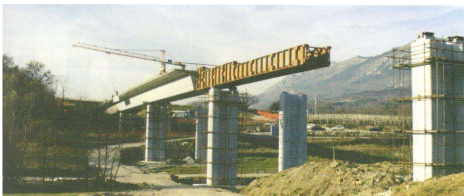
Izgradnja postepenim potiskivanjem RK
