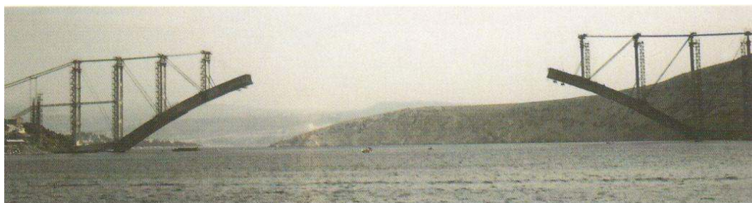
Izgradnja lučnog AB mosta Krk
